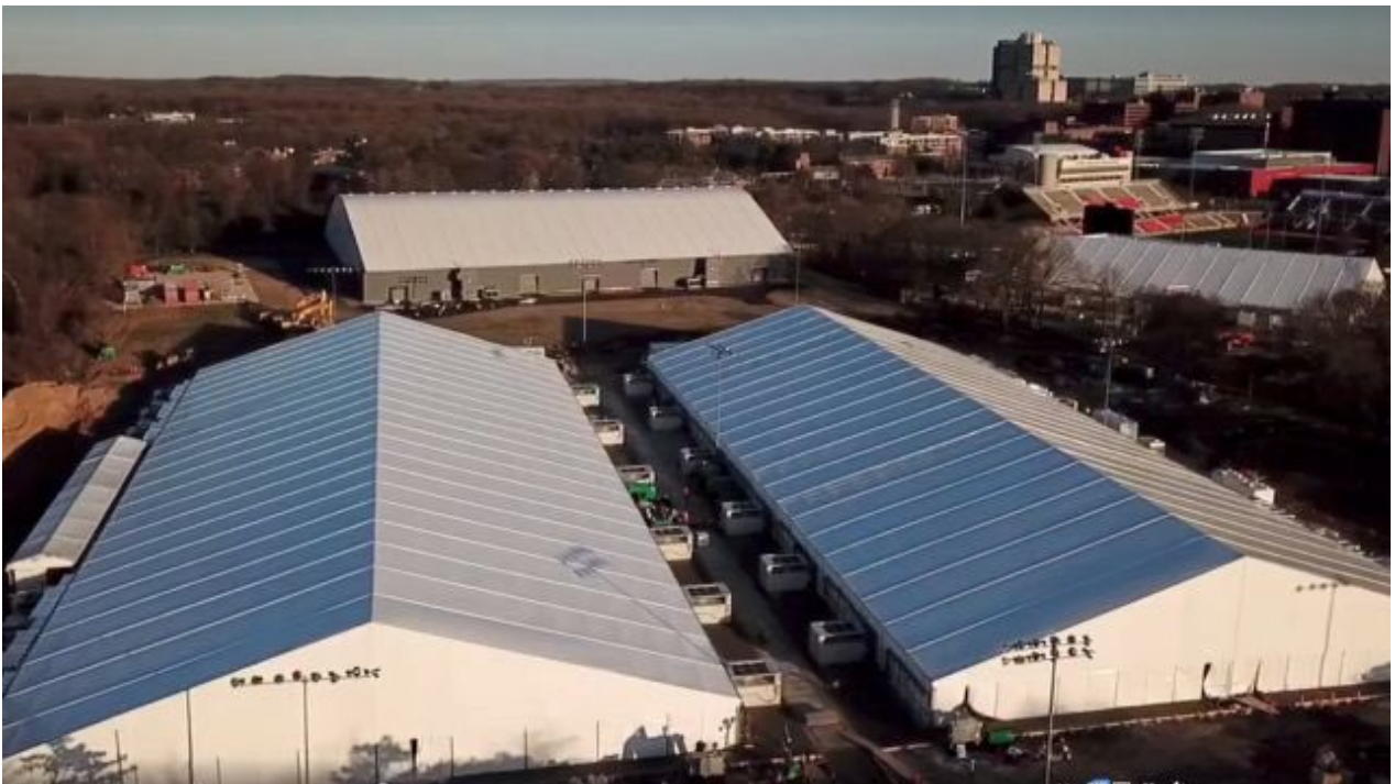
Le baracche di isolamento fatte allestire dal sindaco Cuomo nel campus della Stony Brook University, New York.
