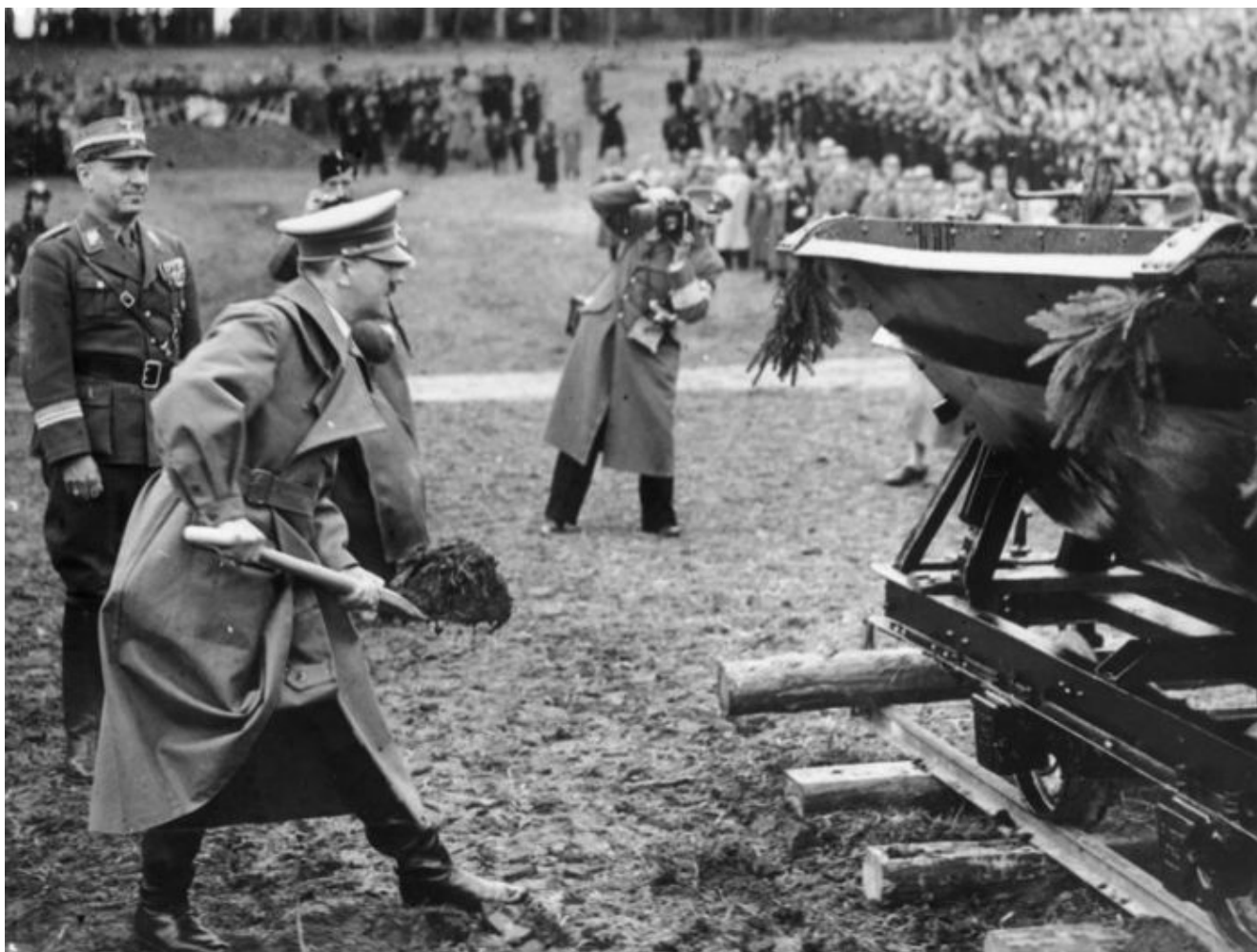
Hitler, avvio dei lavori della grande autostrada austriaca
